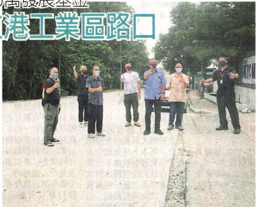
■神建华（右3）与厂家巡视提升后的道路。
